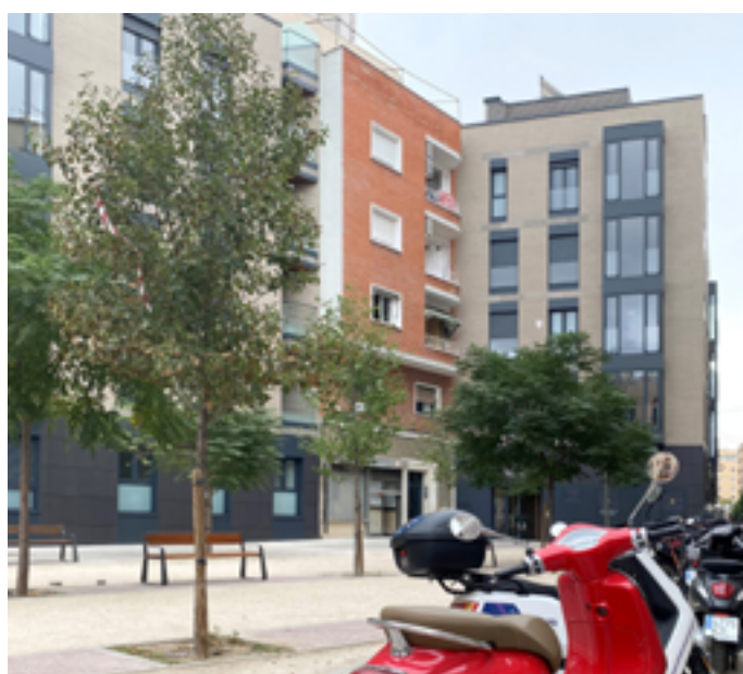
Plaza entre edificios A y B
